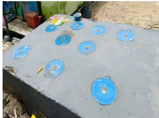
Pembangunan IPAL Komunal 33 KK RT 31 Karang Anyar Pantai
