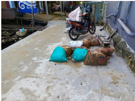
Peningkatan Jalan Lingkungan RT 02 Karang Anyar Pantai
