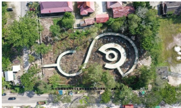
Pembangunan RTH Jl. Pramuka ( Kantor Pemda)
