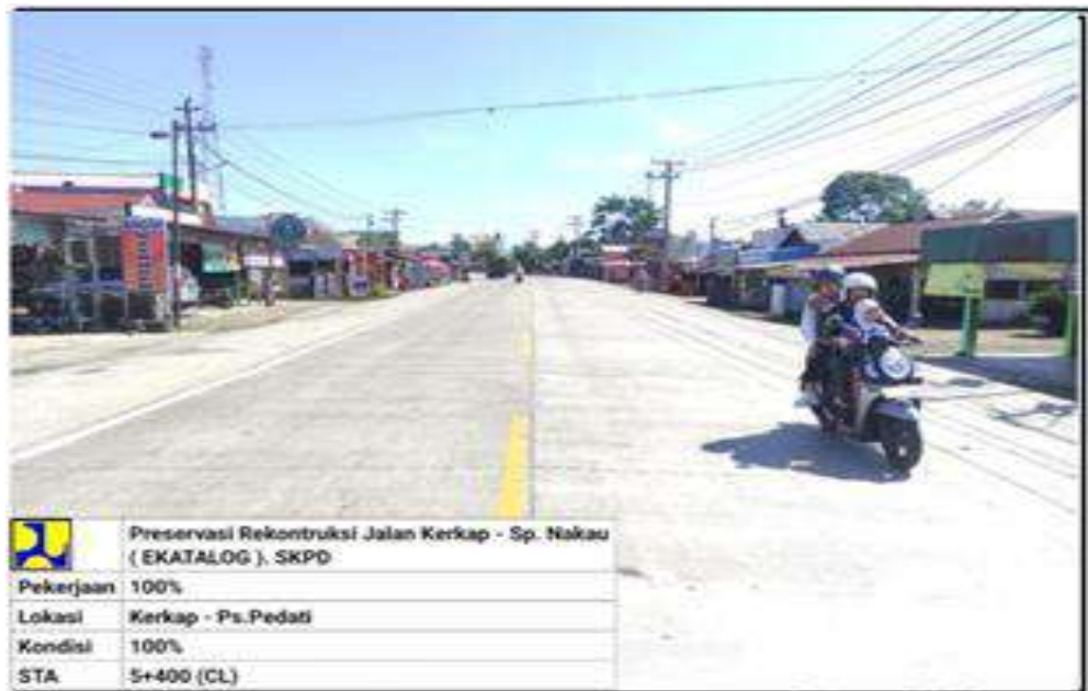
Gambar 4.15 Rekonstruksi Jalan Preservasi Jalan Kerkap – Sp. Nakau (E_Katalog)
