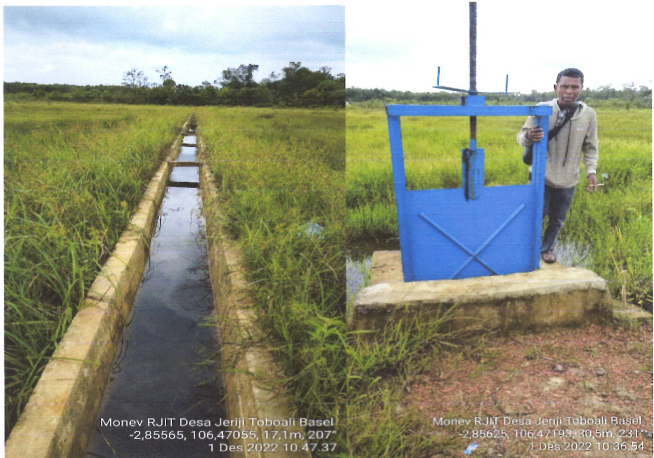
Gambar 5. Rehabilitasi Jaringan Irigasi Tersier
