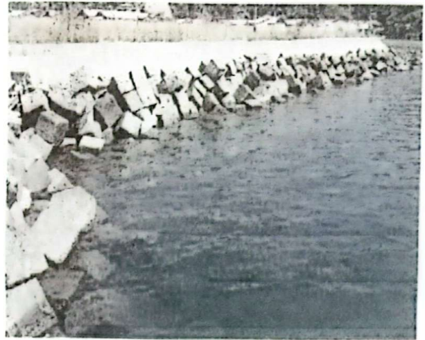
Tembok Pemecah Gelombang
