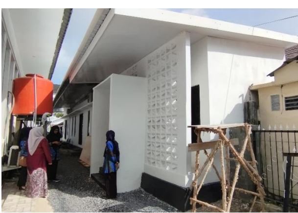
Dokumentasi (100%) Pembangunan Musholla Kantor DISPORABUDPAR
