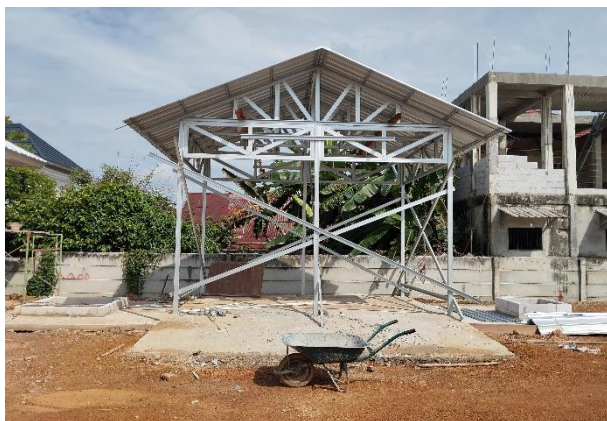
Pembangunan Rumah IPAL
