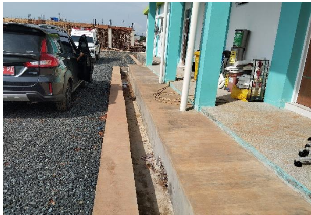
Pembuatan Drainase Keliling Gedung
