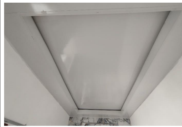
Pemasangan Plafon Musholla Kantor DISPORABUDPAR
