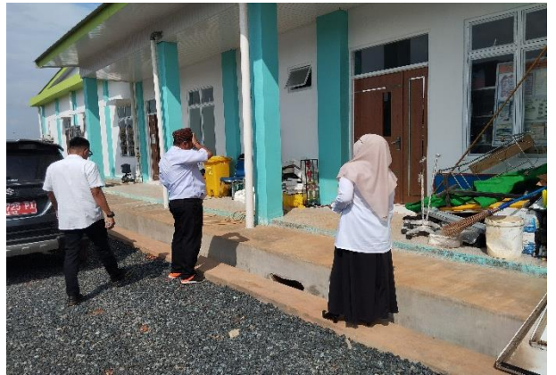
Pembuatan Selasar Keliling Gedung
