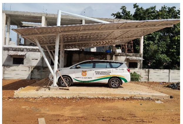
Pembangunan Parkir Ambulance
