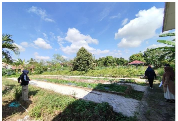
Dokumentasi (100%) Pembuatan Jalan Paving Block Demplot UPT BPP Banjarbaru
