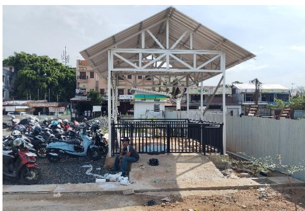
Pembangunan Rumah Genset
