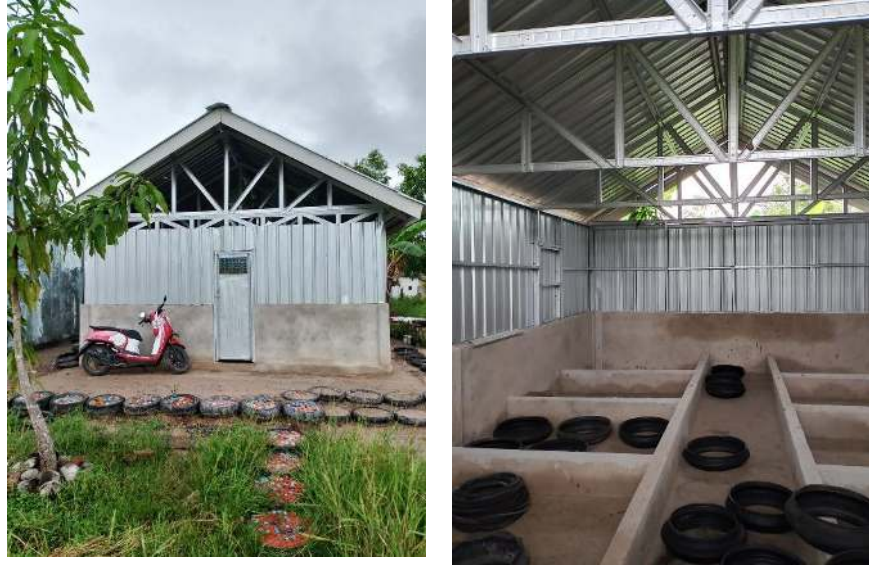
Gambar III-42. Pembangunan Hanggar Budidaya Maggot di Kelurahan Pamusian
