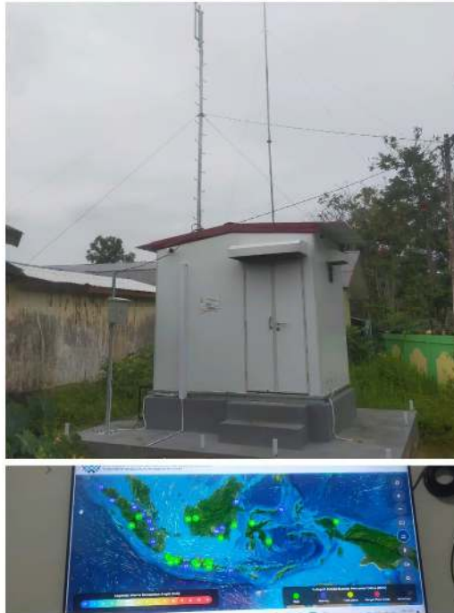
Gambar III-13. Dokumentasi Penempatan Stasiun Pemantau Kualitas Udara Ambien di Halaman Kantor DLH Kota Tarakan
