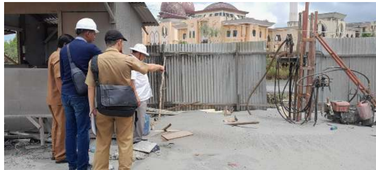
Gambar III-31. Dokumentasi Peninjauan Semburan Gas
