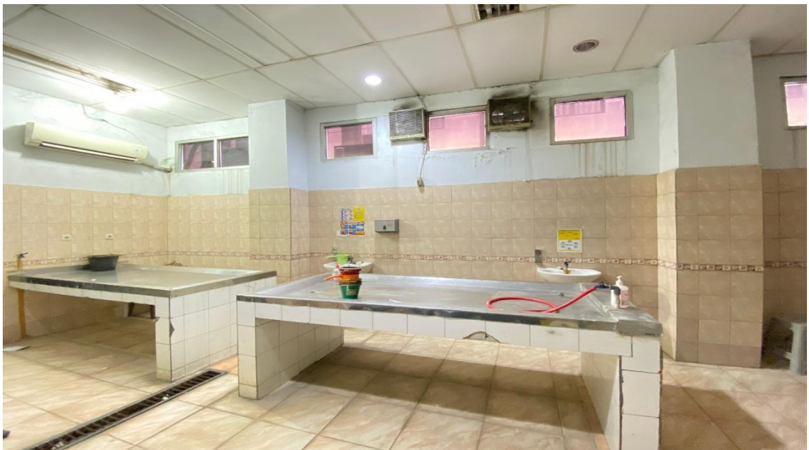
RUANG PELAYANAN PEMULASARAAN JENAZAH
