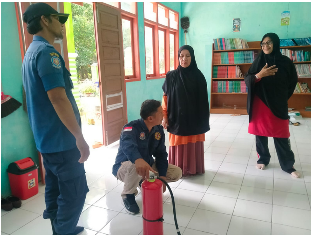
Inspeksi Pengecekan Kondisi APAR
