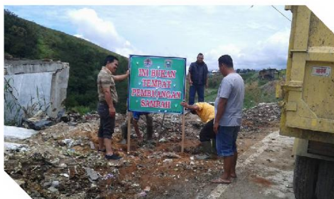
Pemasangan plang informasi
